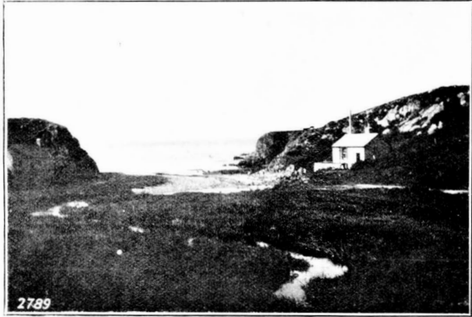
1.—ABERGEIRCH CABLE HUT, NEVIN.
