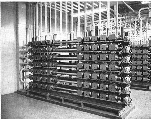
FIG. 4.—THE 7 × 14 MATRIX EXCHANGE FOR THE 30 kW TRANSMITTER GROUP
