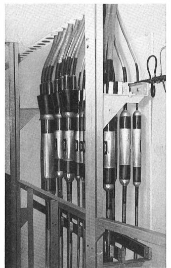
THE CABLE CHAMBER AT STAMFORD EXCHANGE SHOWING THE DOUBLE TACKING BARS
