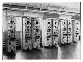
FIG. 11.—INDEPENDENT-SIDEBAND RECEIVERS AT BEARLEY RADIO STATION.
