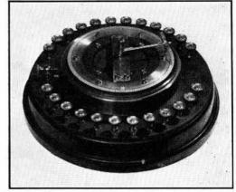
FIG. 1.—DELANEY MULTIPLEX DISTRIBUTOR (1882).
