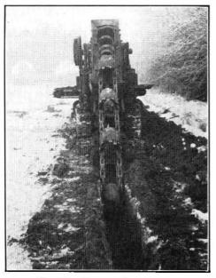
FIG. 13 .- TRENCH EXCAVATOR.
