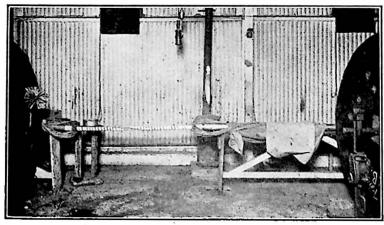
FIG. 3.—" UNIDIAMETER " JOINT PARTIALLY COMPLETED.
