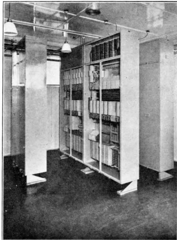
FIG. 6.—"A" RACKS, PLYMPTON U.A.X.7.
