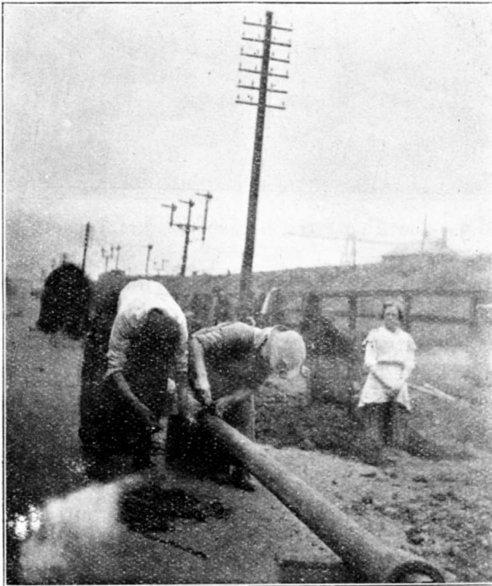
2.—CAULKING PIPES.
